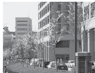
写真1 桜並木完成当時(2005年)
