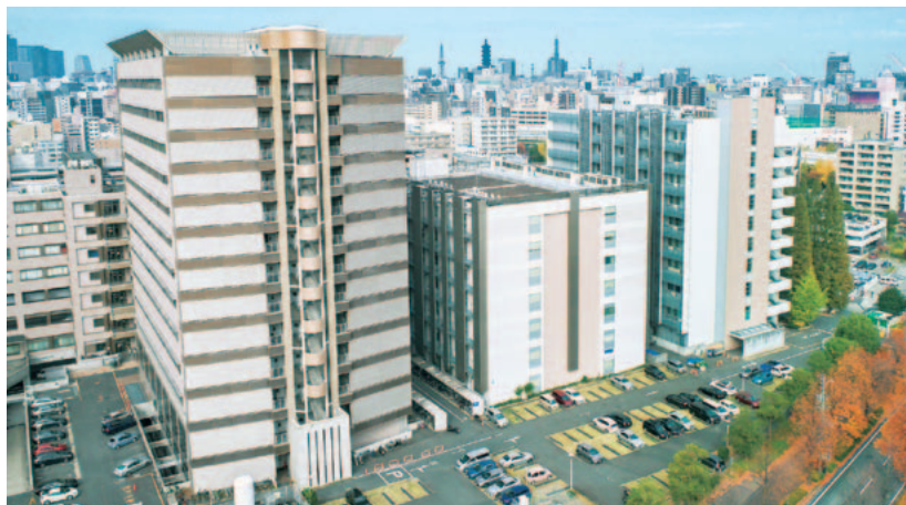
医学系研究棟1・2・3号館
