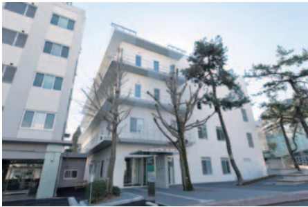
写真1 RI 実験棟完成
