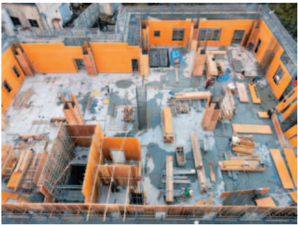
写真3 RI 実験棟建設（2階壁構築中）
