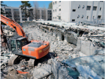
写真2 解体される旧館
