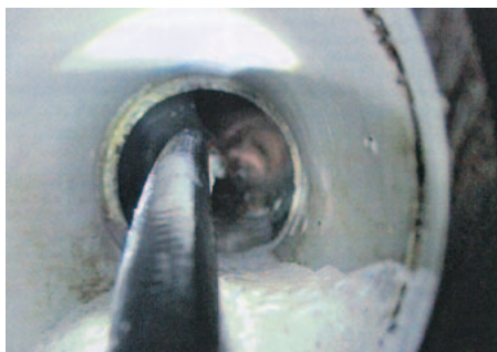
写真1 排水管の高圧洗浄作業
