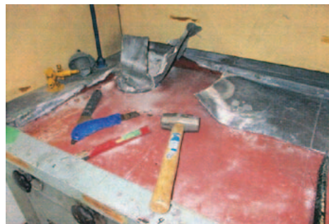
写真3 フード作業面の鉛の剥ぎ取り作業
