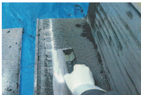
写真2 排気ダクトの除染作業
