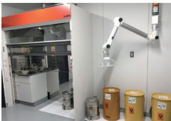
写真11 保管廃棄作業室のウォークインドラフトおよび局所排気設備
