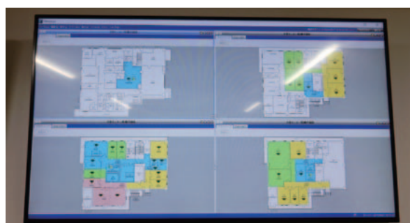
写真 5 給排気稼働状況表示モニター 稼働中の給排気装置がコントラストで表示され、何階のどのエリアに人がいるか判る。
