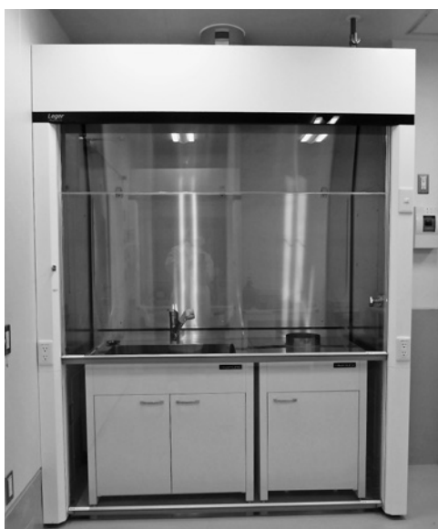
写真10 ドラフト流し（X線照射室，廃棄実験室） 内部被ばくの恐れのある廃液等はここで取り扱います。
