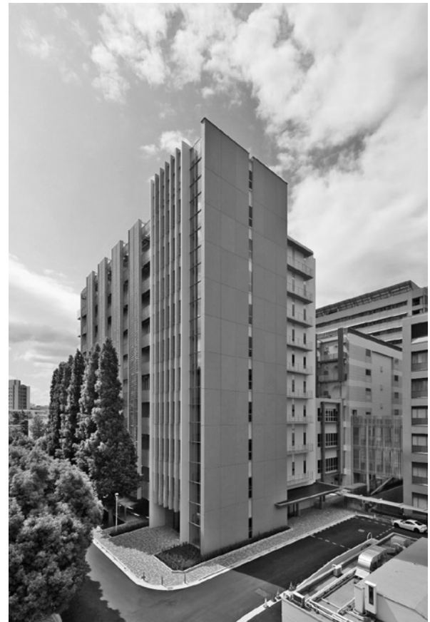
写真1 医系研究棟3号館 （当センターは1階と地下1階に設けられています。）
