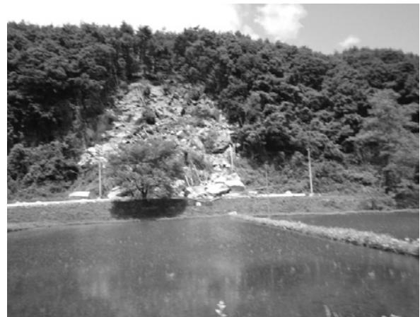
写真 f 崖崩れ現場
