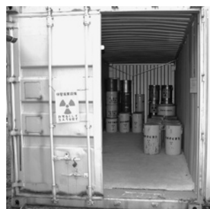
図1 保管廃棄設備 船舶用コンテナを使用しており、同様の物が他に4つある。
