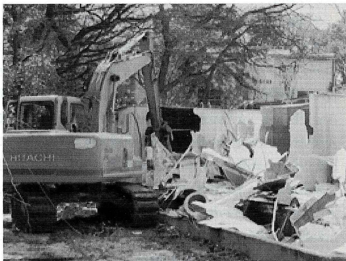
減衰槽解体の様子
