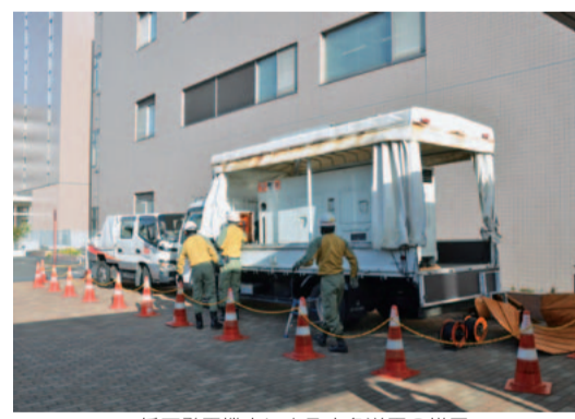
▲低圧発電機車による応急送電の様子
