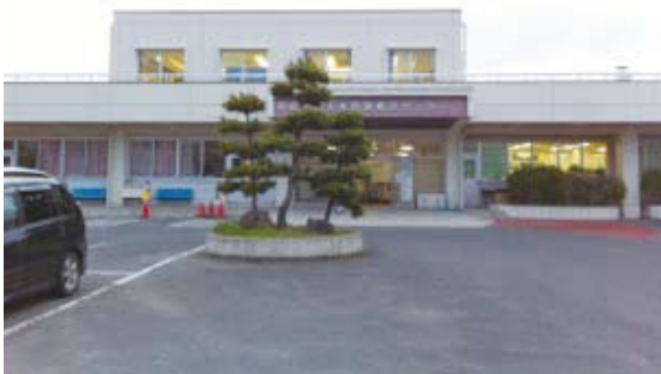
活動拠点となった矢本保健相談センター
