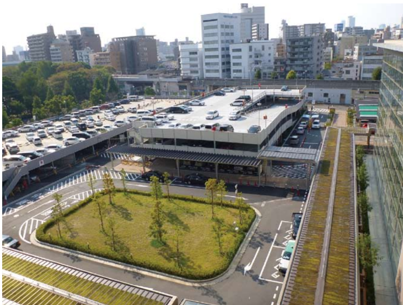
完成した立体駐車場及び歩廊
